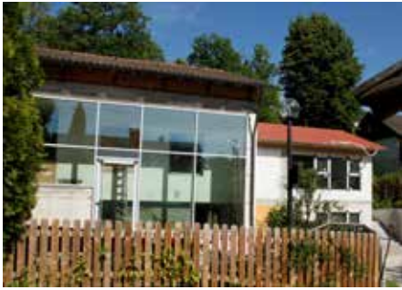
Hinter der großen Glasfront befindet sich das neue Treppenhaus des Kindergartens.
